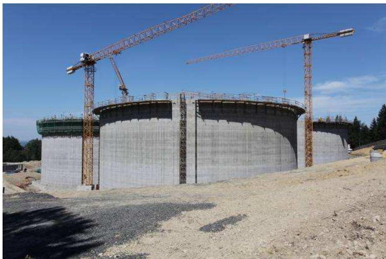
Obr. 1.: Pohled na stavbu nádrží
