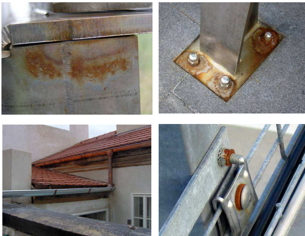
Obr. 1.: Příklady nevhodného konstrukčního a materiálového řešení
