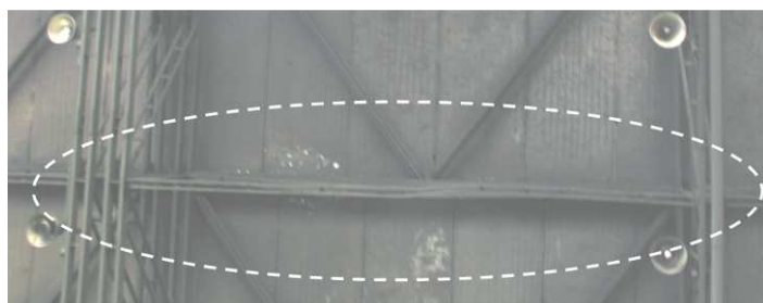
Obr. 3.: Zdeformované pozdĺžne vertikálne strešné diagonálne stužidlá haly
