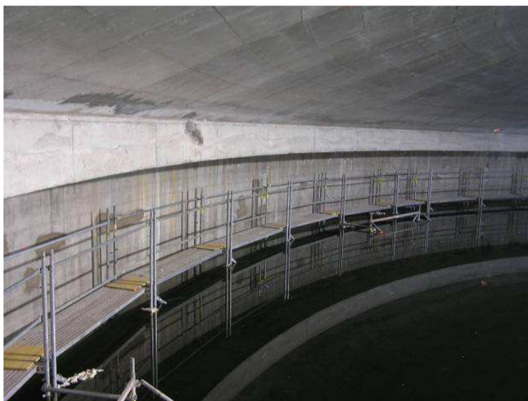
Obr. 2.: Voda v nádrži při zatěžovací zkoušce se zatopeným lešením
