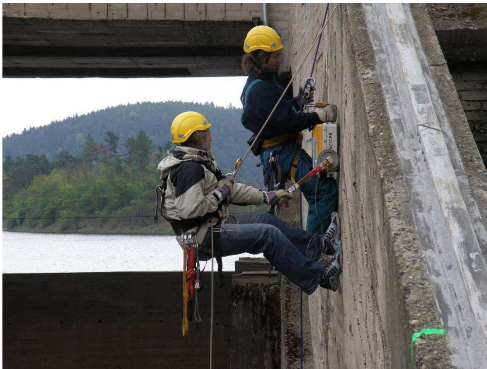
Obr. 2.: Systém RAMAC umožňuje díky své kompaktnosti práci i ve velmi složitých podmínkách. Ukázka z průzkumu až 18 m vysokých stěn lodního zdvihadla na VD Orlick prováděného horolezeckou technikou.
