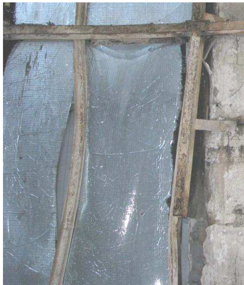
Obr. 2.: Zdeformované stĺpy a priečniky na uchytyvanie opláštenia haly
