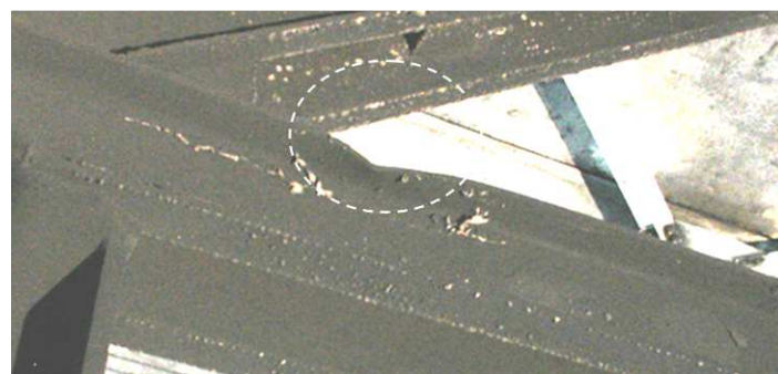
Obr. 5.: Zdeformovaný dolný pás väzníka (nad ohniskom požiaru)
