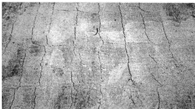
Obr. 1.: Typické smršťovací trhlinky nad výztuží v železobetonu (převzato z [4])
