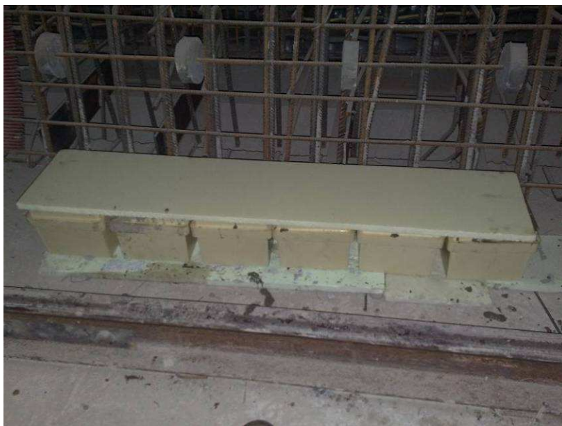
Obr. 8.: Příklad vhodnějšího uložení těles na stavbě při nízké teplotě
