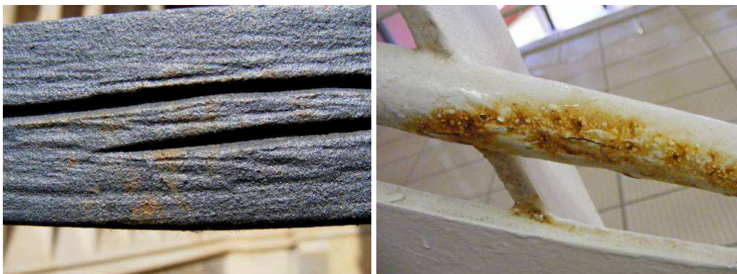
Obr.4: Korozní napadení na hranách
